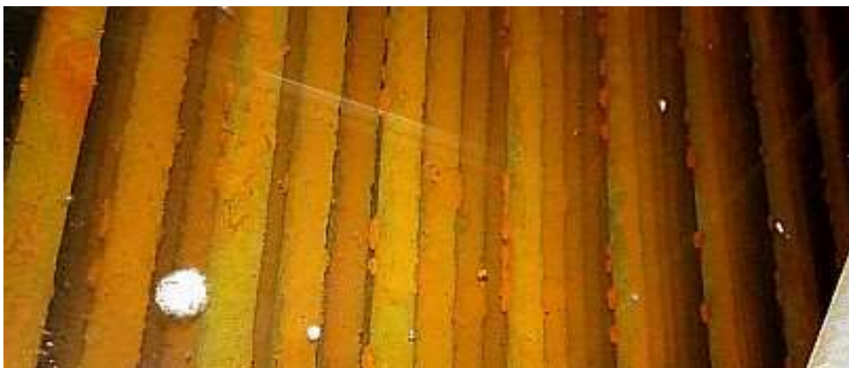
Bild på kylslingorna. Dessa är täckta med en flera millimeter tjock biofilm. Inne i sådan kan pH-värdet sjunka så mycket att miljön blir starkt korrosivt.
