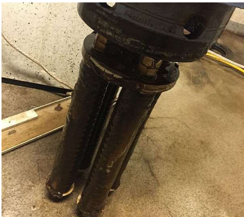
Magnetstavar i filtret fångade upp magnetiska partiklar
