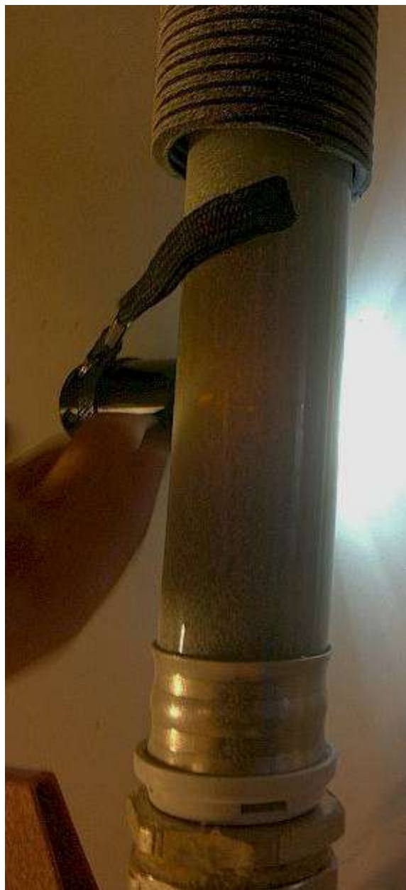
De transparenta slangarna var blockerade av smuts
